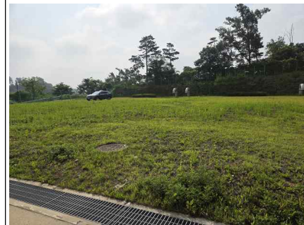
<배수지 상부 전경>
