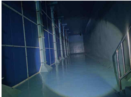
<배수지 1지 전경>
