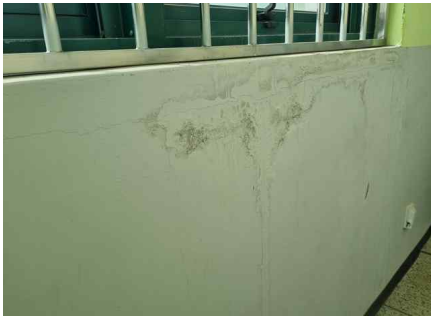
<전기실 벽체 균열>
