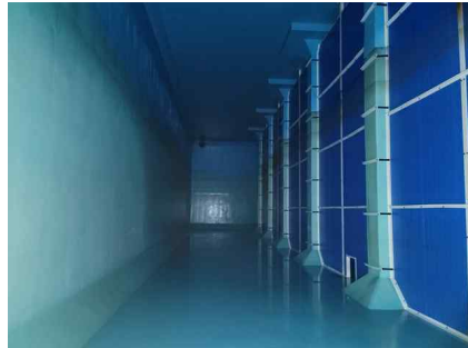
<배수지 2지 전경>
